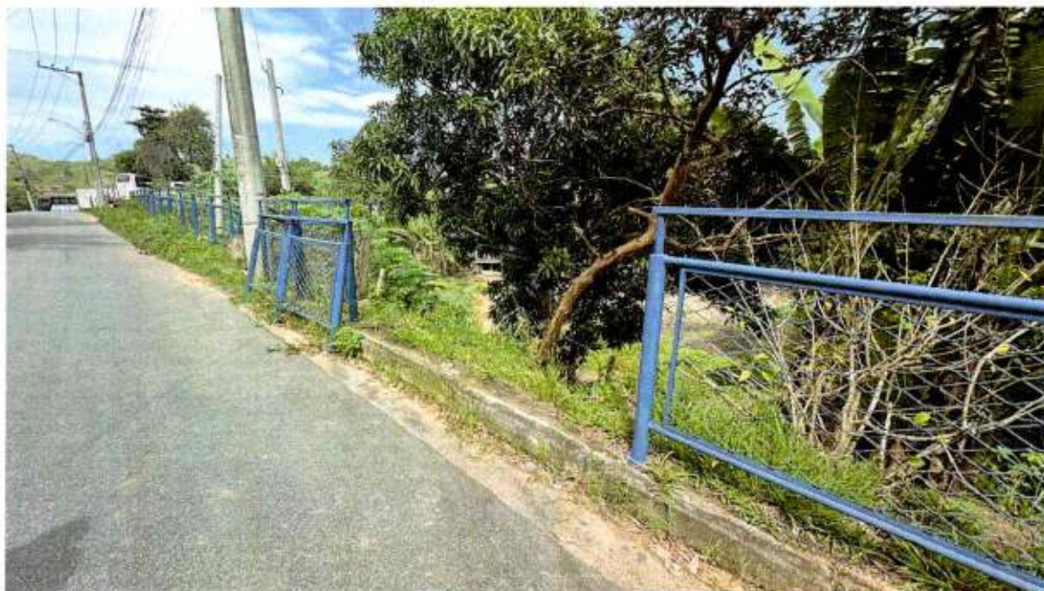
Figura 3 - Visão frontal do terreno a partir da via pública, situado na Rua Adácio Cândido de Matos, s/n.
